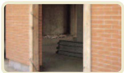
In questo caso le tavole di protezione sono state fissate mediante molle in acciaio.
