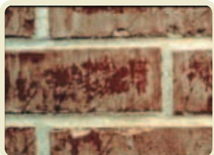
Macchie provocate da un pessimo lavaggio con acido cloridrico (muro non sufficientemente bagnato prima della pulitura, e non adeguatamente risciacquato dopo). L'acido ha corroso il legante della parte superficiale dei giunti di malta, favorendo così il deposito di silicati sui mattoni.
