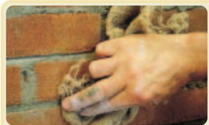
*Il muro va pulito appena completato, senza attendere l'indurimento completo della malta, mediante stracci, spugne o spazzole morbide, rigorosamente puliti, e mai mediante spazzole in ferro od altri abrasivi, che modificano la superficie del mattone.*
