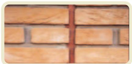
I giunti orizzontali di malta ai lati del giunto di dilatazione vanno costipati accuratamente, per evitare che il materiale con cui il giunto viene riempito si espanda in essi, provocando effetti estetici poco piacevoli.
