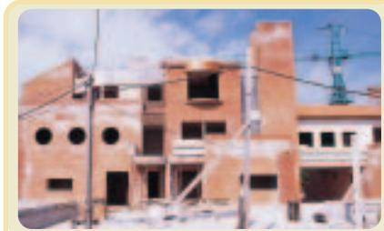
*I muri non protetti durante la costruzione si sono vistosamente coperti di efflorescenze...*
