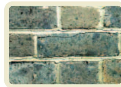
Se l'efflorescenza compare come un orlo intorno ai mattoni, è segno che i sali sono contenuti nella malta (probabilmente contenente cemento Portland) e sono trasmigrati nel laterizio a causa di una errata posa (per esempio, con temperatura ambiente molto elevata).
