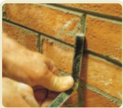
Forse ancora più importante della stilatura dei giunti orizzontali è quella dei giunti verticali, lungo i quali l'acqua, scorrendo, può infiltrarsi con facilità attraverso qualsiasi minima imperfezione.
