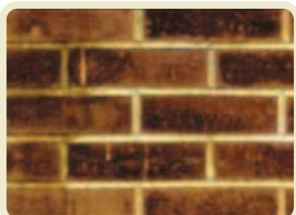
Brucciatura causata da una soluzione troppo concentrata usata per pulire un muro non sufficientemente bagnato: l'acido reagisce con malta e mattoni portando in superficie vari sali.
