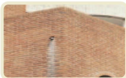
Vistose colature di calce, difficili da rimuovere, dovute alla mancanza di un adeguato sistema di scarico inserito nella muratura durante il cantiere, prima della posa delle guaine impermeabilizzanti.
